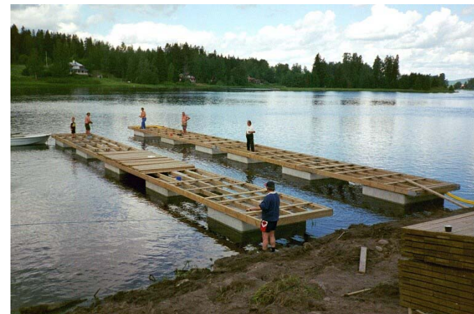
Med gemensamma krafter byggs bryggor i ett projekt inom Leader+ Nedre Dalälven. Projektet syftar till att utveckla och underlätta för båttrafiken i området mellan Avesta, Grådö och Dala-Husby. Foto: Krister Larsson
