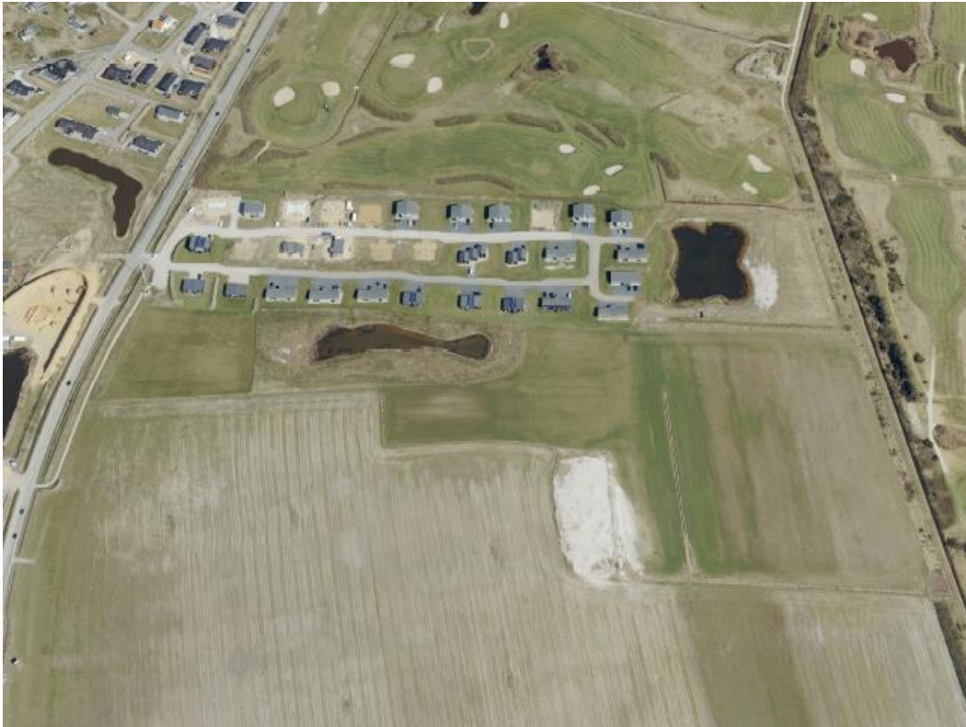
Figur 17 Skråfoto set mod nord af de feriehuse, som Keld Hansen på billedet var påbegyndt opførelse af. I deres fremtræden kan udenforstående have svært ved at adskille disse fra sommerhuse. (Kilde:
